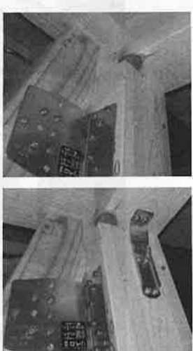
【図2】必要な金物が設置されていなかった実例
